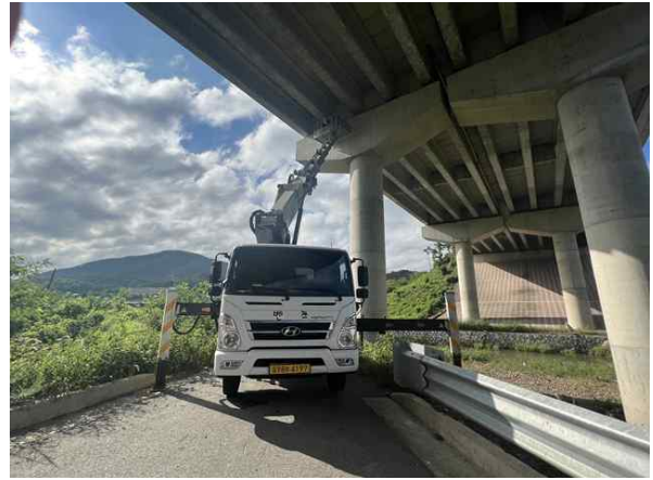
고소점검차를 이용한 근접조사
