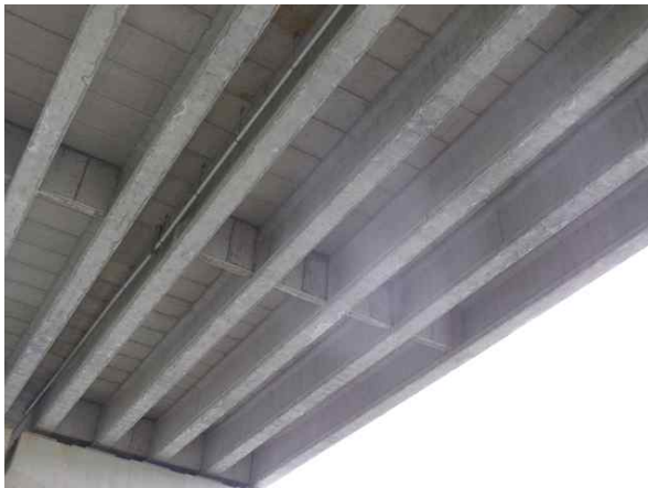
거더 및 바닥판하면 전경
